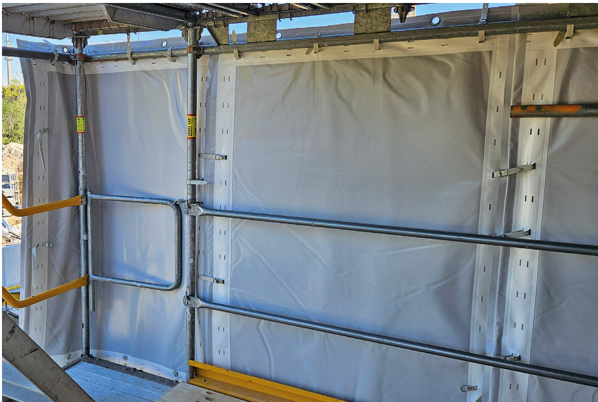
Image 4 : Fixation au montant de l'échafaudage, raccordement de Cisilent au milieu du champ d'échafaudage
