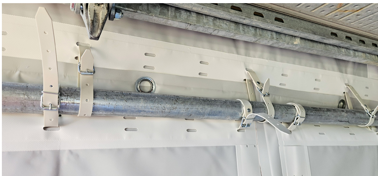
Image 3 : Fixation à la traverse de l'échafaudage, chevauchement supérieur
