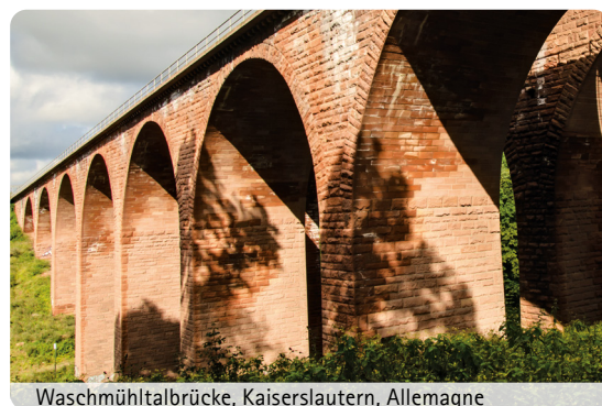
Waschmühlentalbrücke, Kaiserslautern, Allemagne
