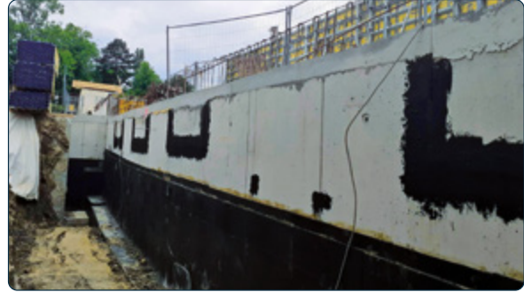
Montage sur la paroi de cave
