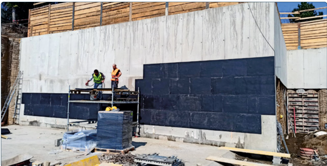
Montage sur un mur de soutènement
