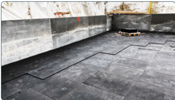
Montage multicouche sous la dalle de fondation
