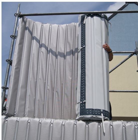
Illustration 3 : déroulement sur un pan d'échafaudage
