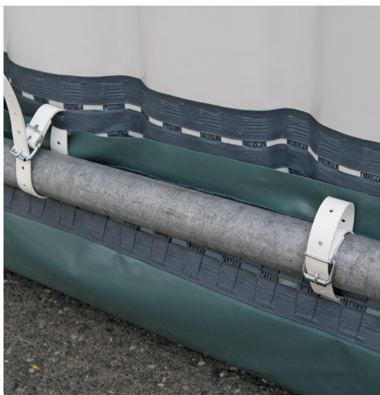
Illustration 8 : fixation de la bande de fermeture sur la barre de l'échafaudage
