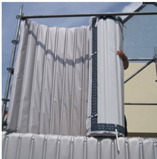
Illustration 3 : déroulement sur un pan d'échafaudage
