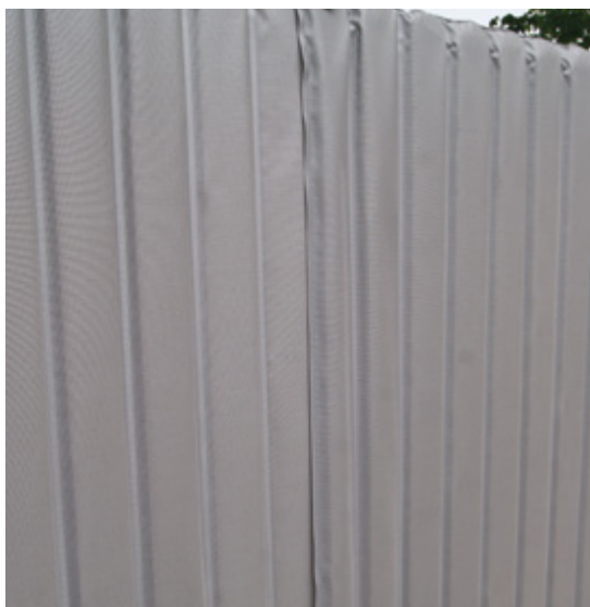
Illustration 6 : chevauchement étroit des bordures
