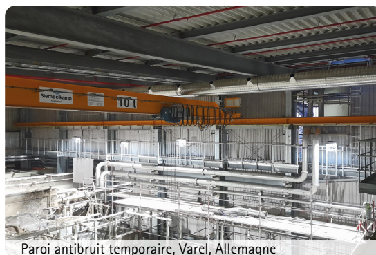
Paroi antibruit temporaire, Varel, Allemagne
