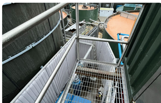
Coffrage de l'installation de refroidissement, Irlande
