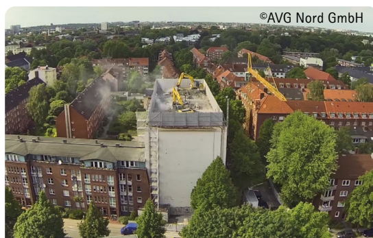
Écran de protection antibruit, démolition de bunker, Hambourg, Allemagne
