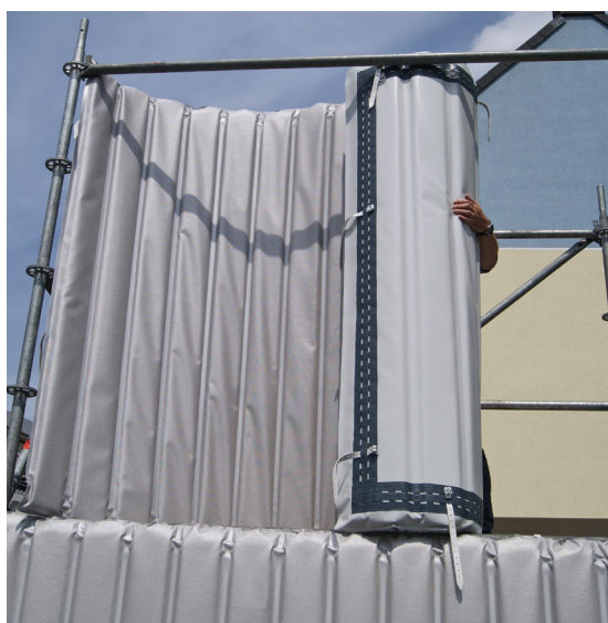
Déroulement sur un pan d'échafaudage
