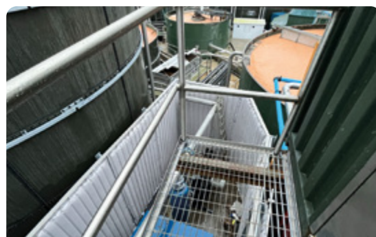
Coffrage de l'installation de refroidissement, Irlande
