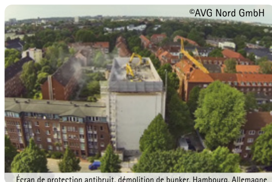
Écran de protection antibruit, démolition de bunker, Hambourg, Allemagne
