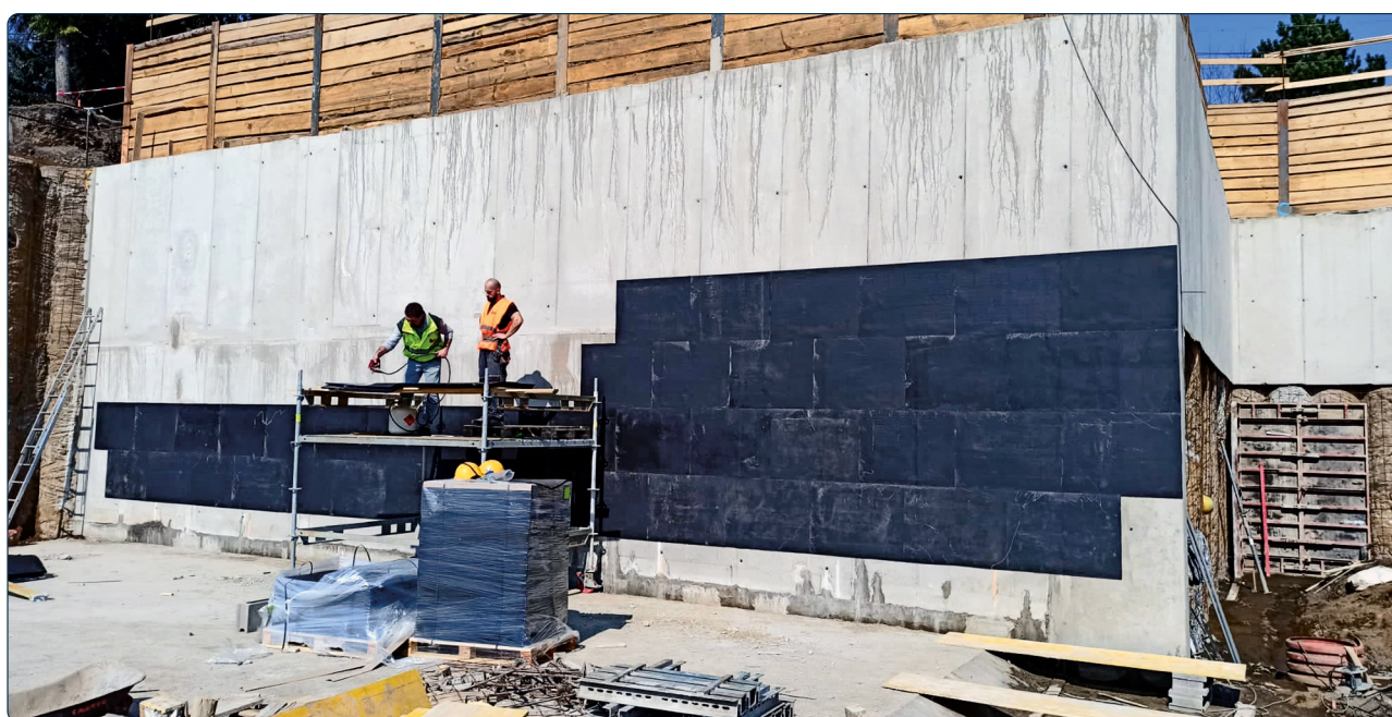
Montage sur un mur de soutènement
