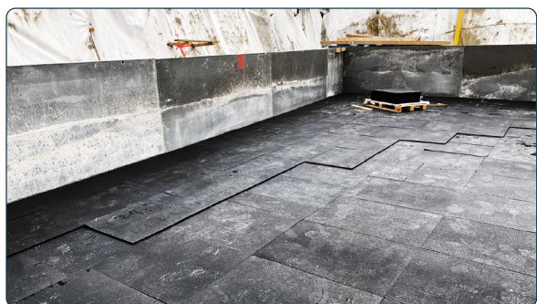
Montage multicouche sous la dalle de fondation
