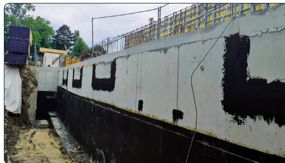
Montage sur la paroi de cave
